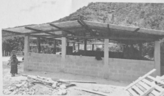
Foto 4: Finalización del techo y estructura.
