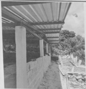
Foto1: Finalización del trabajo tipo portico.
