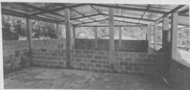
Foto 3: Finalización y fundición de piso.
