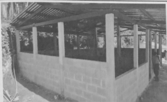
Foto 5: finalización del trabajo, pegado de block y techo.
